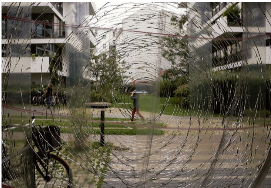
Zerstörte Fensterscheibe in Neubau: Serie von Angriffen
